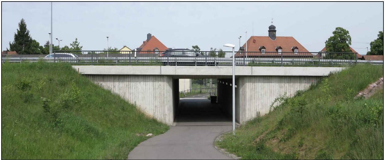
Abbildung 20: Hafenzufahrt "OST" - Unterführung unter der B 26 für Fußgänger und Radfahrer
