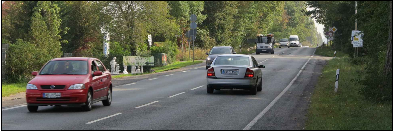
Abbildung 12: B 26 im Bereich der Kohlenkaistraße und der Brücke über die Hafenbahn, Blickrichtung Osten
